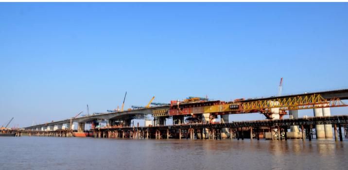
**本报讯** 10月17日,由中交集团自主设计制造的国内最先进2500吨-50米自行式移动模架在温州瓯江南口大桥顺利完成过主桥。自完成北岸左幅21跨50米箱梁后,该模架历时20天自行通过通航孔主桥到达南岸,使得南岸剩余50米箱梁具备新一轮施工条件。
