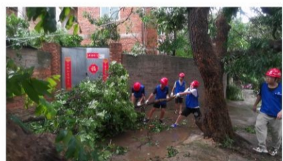
缆风绳牢固程度和生产物资绑扎封存、设备停放情况等，各项工作有条不紊推进。
